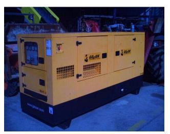
GRUPO ELECTRÓGENO MODELO: GESAN DESCRIPCIÓN: Grupo electrógeno con 70 kvas de potencia. Monta motor perkins de 6 cilindros. Esta en perfecto estado de funcionamiento, totalmente revisado.
